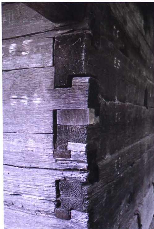
Fig. 3.53. Biserica în locația sa actuală. Îmbinarea bânelor în cheotoare în dinte (foto: Timur, V.C., 2017)
