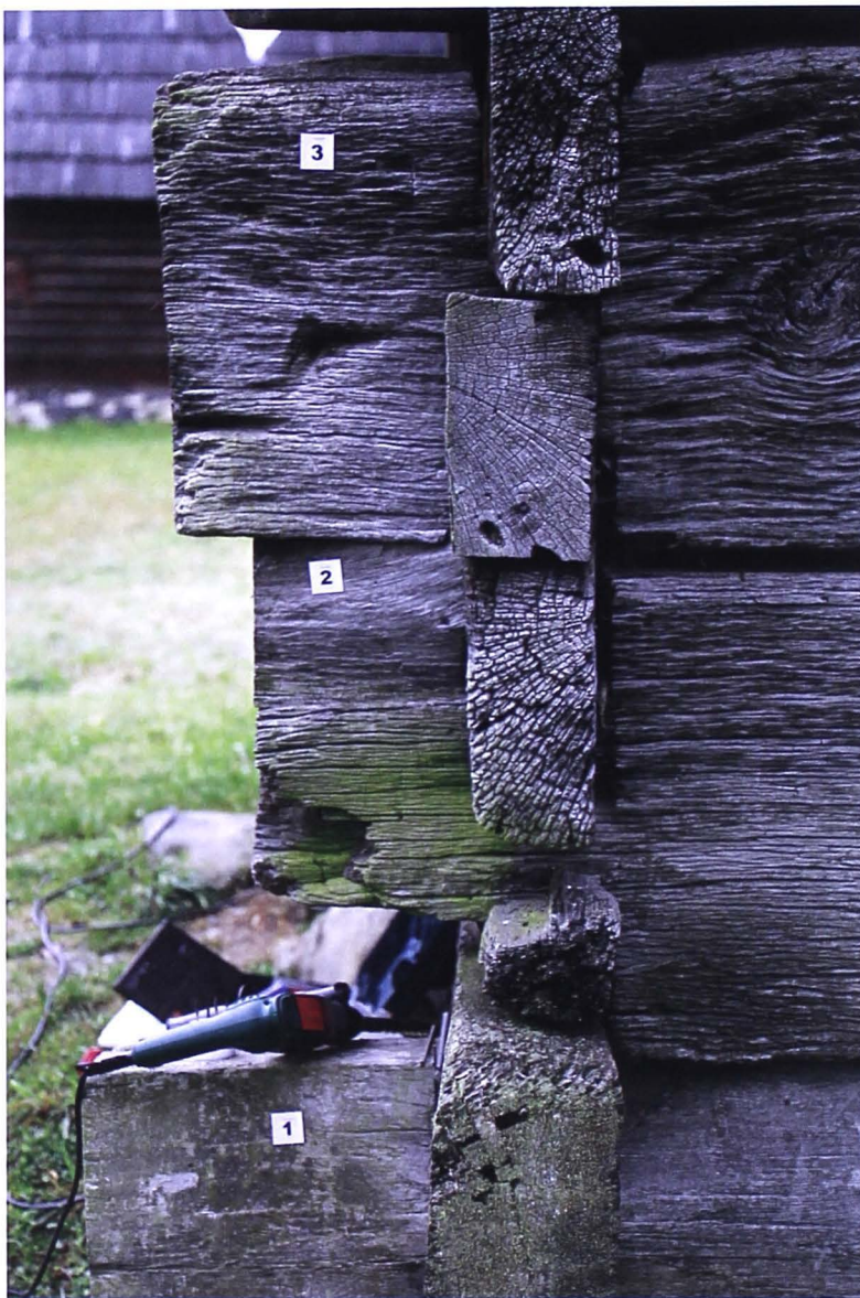
Fig. 3.63. Cheotoare dreaptă românească, ieșitura în afara îmbinării
