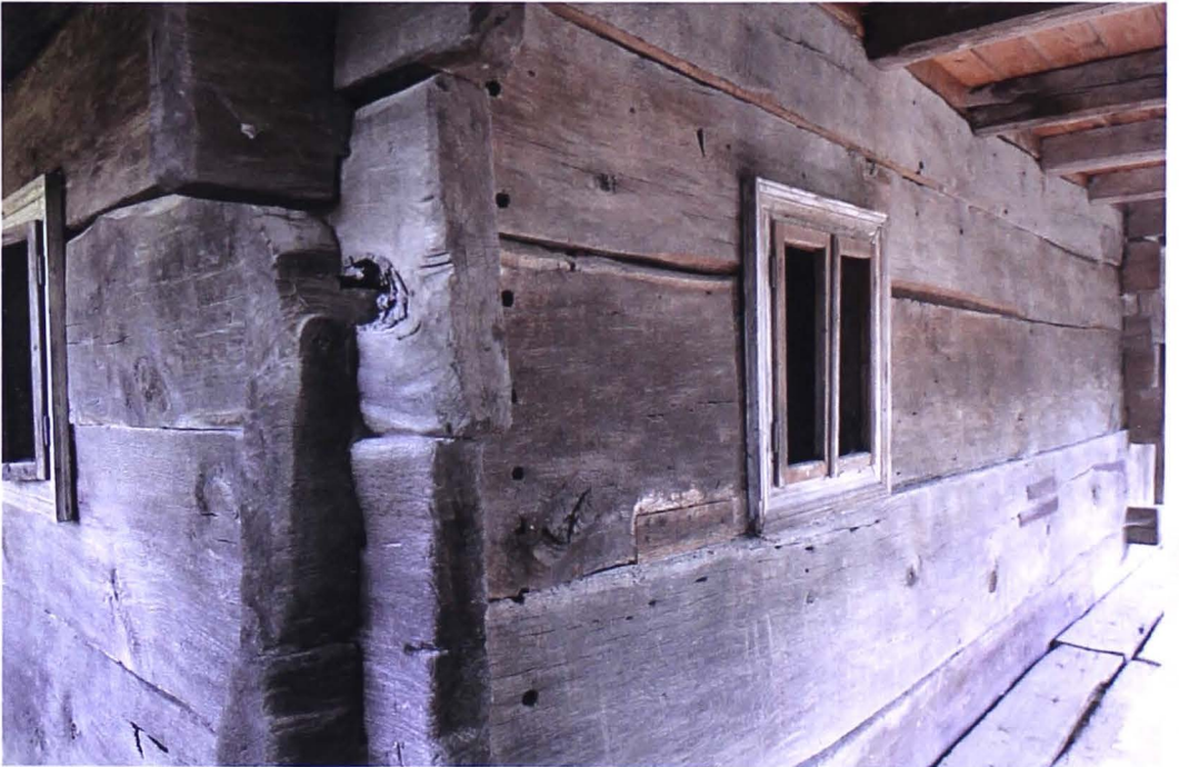
Fig. 3.59. Casa Bud-Dunca, îmbinarea în cheotoare dreaptă românească. (foto: Timur, V.C., 2017)
