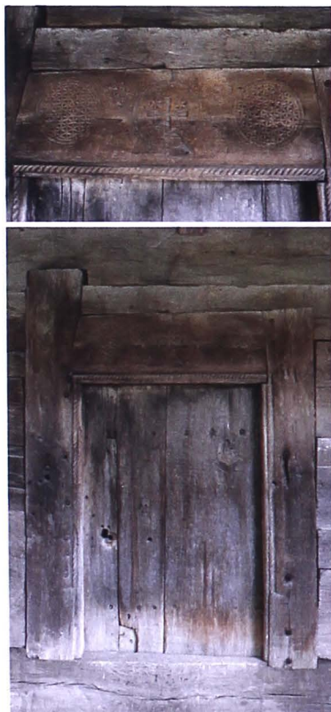
Fig. 3.60. Ancadramentul ușii cu detalii elemente decorative. (foto: Timur, V.C., 2017)
